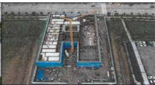
'24년 7월 현재 3층 바닥 시공 중
