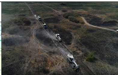
주보급로 보수 (공사)
