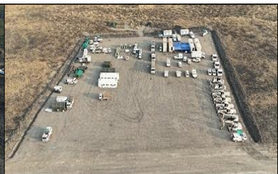
주보급로 보수 (임시숙영)
