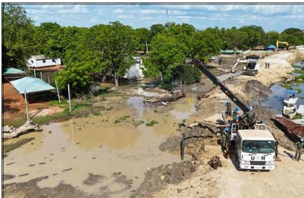
침수지역 제방 설치 및 배수시설 정비
